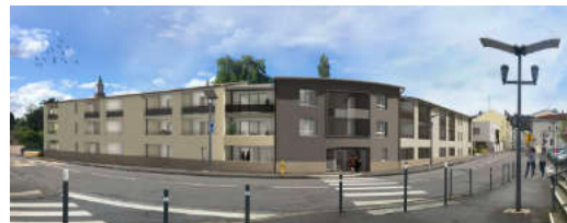
MALZÉVILLE Résidence La Maisonnée, 40 logements à destination des séniors. Agence DYNAMO Associés
