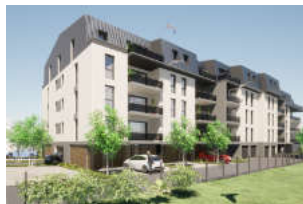
ESSEY-LÈS-NANCY Résidence Rosa Bonheur, 46 logements. NOVAYA Architecture
